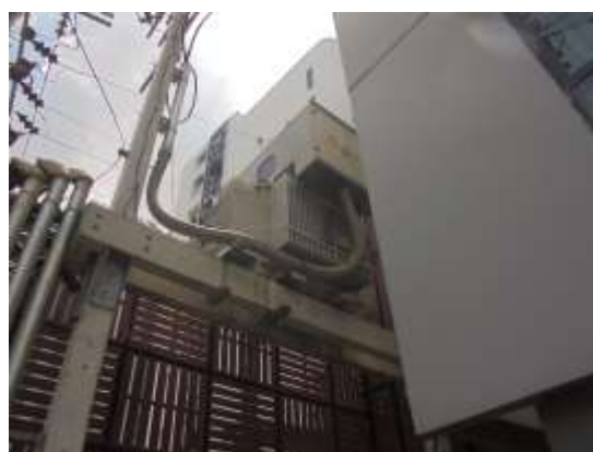
รูปที่ 22 ติดตั้งหม้อแปลงไฟฟ้า
